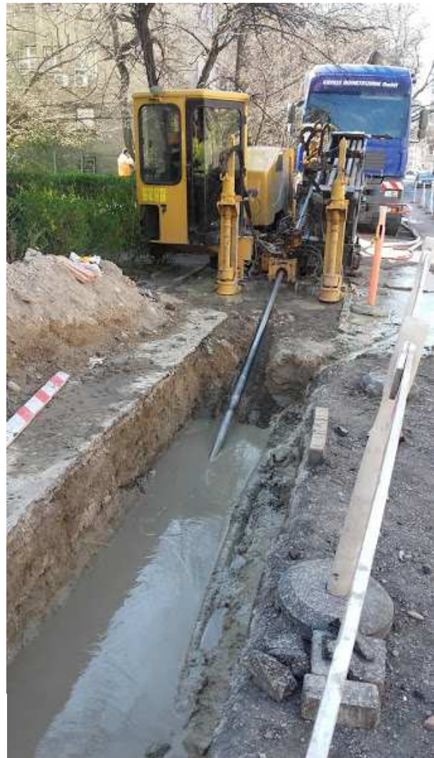
15. ábra Fűrőberendezés és öblítőfolyadék (ferde fűrás a Karinty Frigyes út alatt, saját felvétel)
