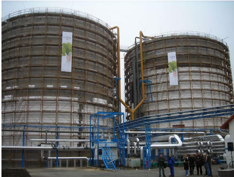
2 db 13 000 m 3 reaktor (29 m magas, 25 m Ø)
